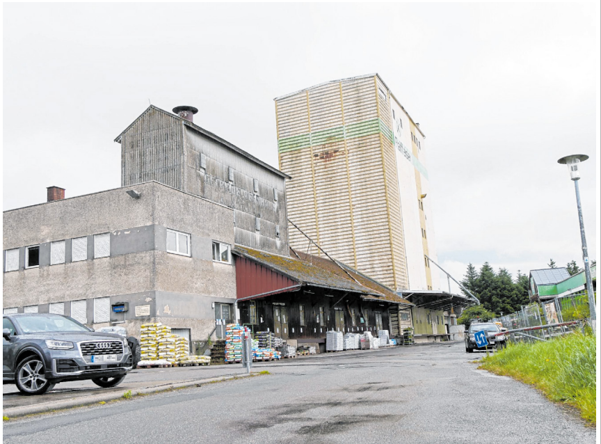
Das Lagerhaus mit Getreidesilo in der Eisenbahnstraße wird ab dem 8. Juli abgerissen. Wie es danach mit dem Gelände weitergeht, ist ungewiss.
