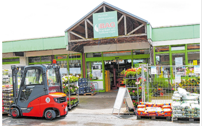
Der Raiffeisenmarkt muss während der Abrissarbeiten geschlossen bleiben.
